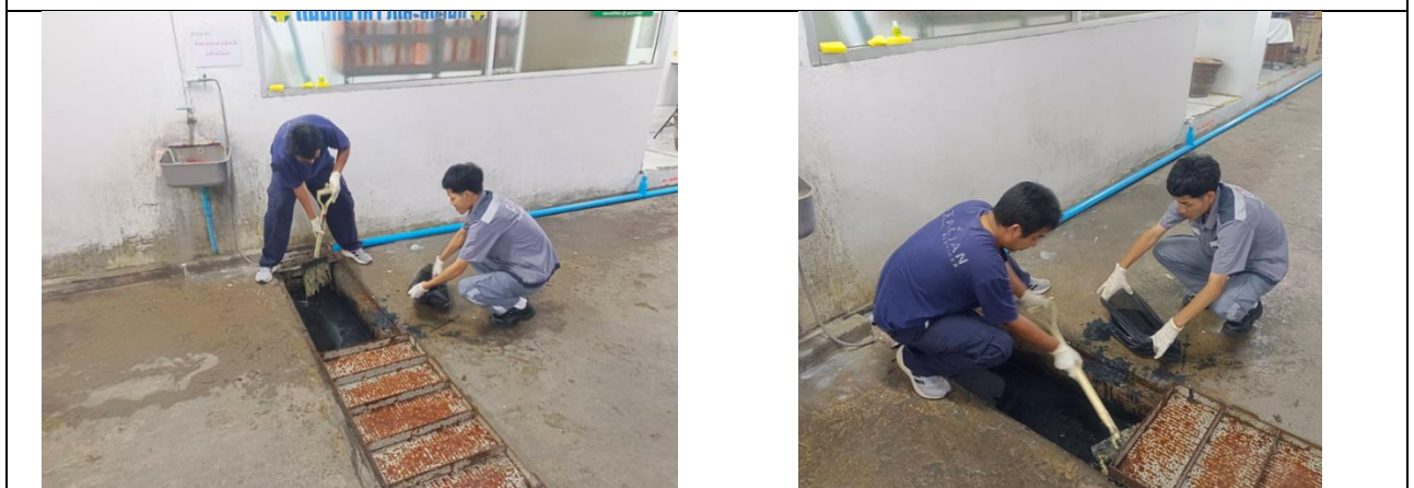
รูปที่ 2.2-31 ขุดลอกท่อระบายน้ำ
